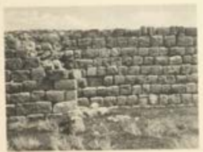
3. — Qasr En-Nasra. — Appareil de la D. digue.
